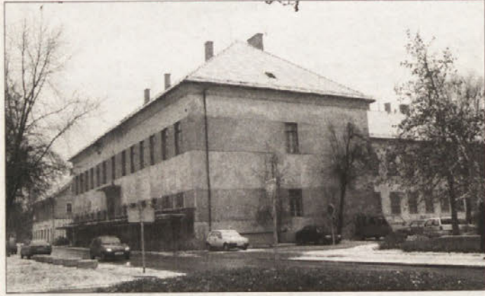
GRADNJA GIMNAZIJE - Stavba bivše in bodoče gimnazije bo takšna, kot je na posnetku, samo še letos. Razen prizidka, ki ga bodo porušili in zgradili novega, bo namreč tudi stari del stavbe imel drugačno podobo, kot smo je vajeni. Sedanja podoba so stavbi nadeli po 2. svetovni vojni, njena prihodnja podoba pa bo narejena po fotografiji, ki datira še iz časa pred 2. svetovno vojno. (Foto: M. L.-S.)
