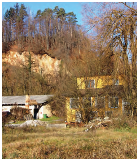
112. Opuščen peskolom gradbenega kamna Podčelo na območju Stare Vrhnike.
