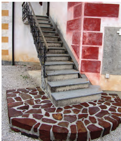
113. Rjavordeč boksit kot okrasni kamen, vzdian v nastopno ploščo stopnišča cerkve sv. Brikcija v Podlipi.
