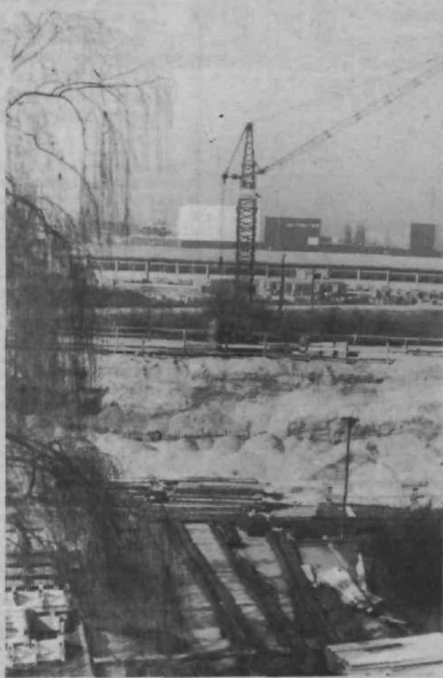
Pri Ljubljanskih mlekarnah na Tolstojevi cesti so že izkopal temelje za novo tovarno za predelavo mleka in za veliko skladišče sirov. Na gradbišču je iz dneva v dan bolj živahno.
