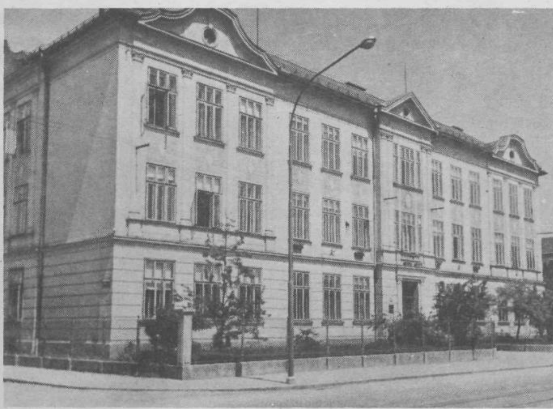
Poslopje VI. gimnazije Moste je zidano pred dobrimi šestdesetimi leti. V stari stavbi ob hrupni Zaloški cesti, je pouk dijakov dokaj težaven
