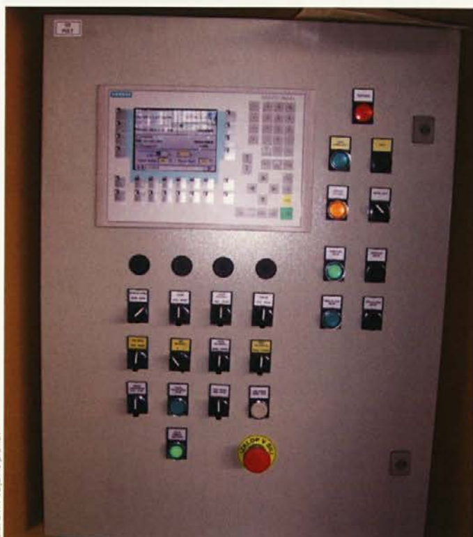
Upravljaljski pult za vodenje in nadzor potopne mize
