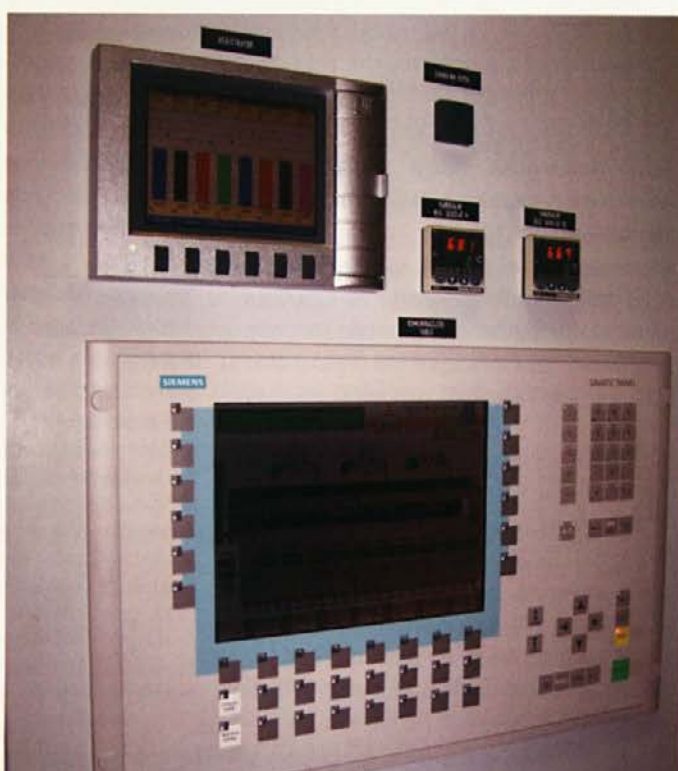
Upravljaljski pult za nadzor in vodenje peči
