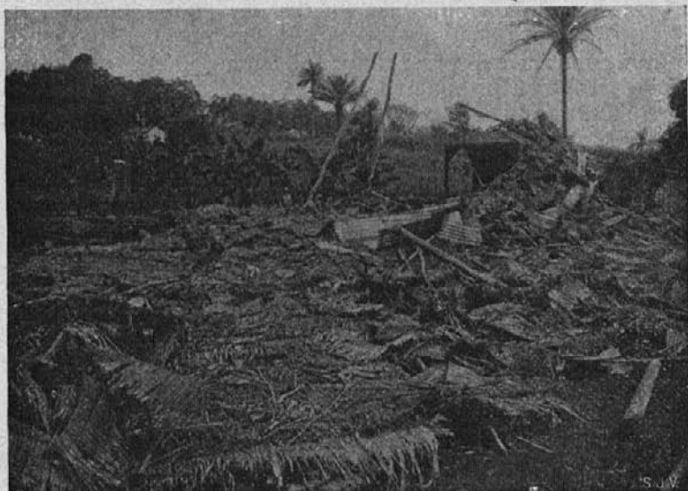
Po viharju. Porušena cerkev v misijonu Soppo.
