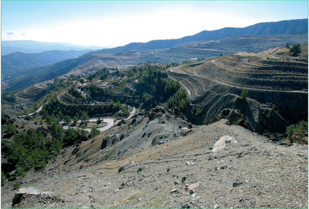
Slika 12: Začetek sanacije rudnika azbesta
