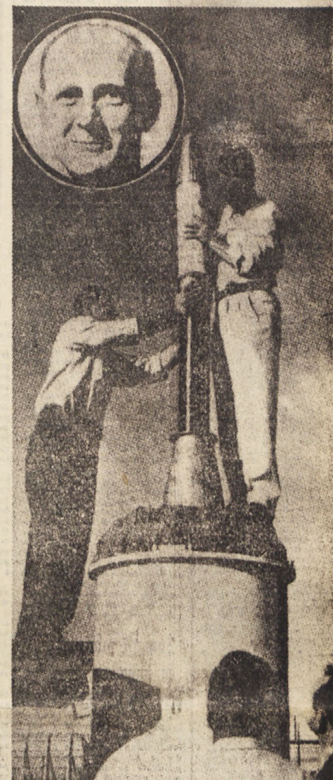
Prva fotografija umetnega satelita ameriške vojske, ki ga dva tehnika nameščata v zadnji del rakete «Jupiter - C». Štiridolno raketo so izdelali v Centru za izstrelke v Huntsville (Alabama), ki ga vodi Werner von Braun. Satelit ima obliko volja s stožčasto konico in tehta 13 kilogramov. Izdelal ga je dr. William H. Pickering, ki ga vidite v gornjem krogu in ki vodi laboratorij za pogonska goriva na politehniški v Kaliforniji.
