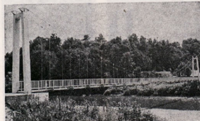
Brv čez Savinjo v Levcu z visečo konstrukcijo
