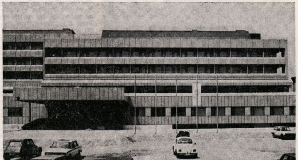
Nova celjska bolnišnica, v pritličju desno že obratuje ambulante.
