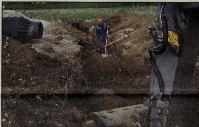
Gradnja sekundarnega kanala v Trnavi
