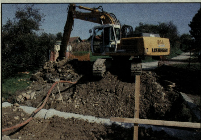
Dela pri mostu čez potok Trebnik v Rakovljah
