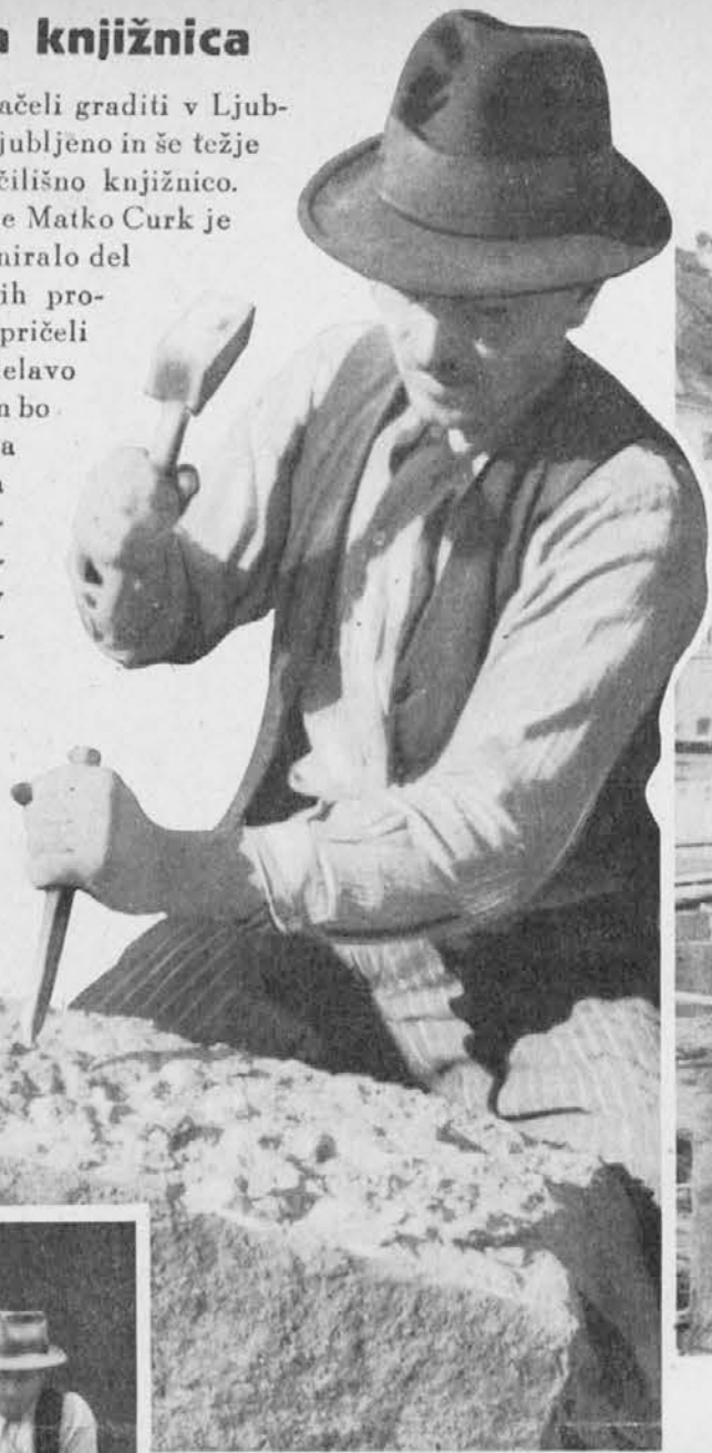
Zgoraj: Kljub pridnemu delu gre oklesavanje kamnov le počasi izpod rok. Na levi: Med kamni, ki pridejo v obdelavo, so mnogi težki po 200 do 300 kg, nekateri celo do 500 kg in tedaj štiri roke ne dvignejo več bremena.
