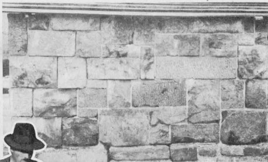
Zgoraj: Za prenovljenim rimskim zidom in grobiščem na Mirju stoji 3 m dolg in 2 m visok zid iz obdelanega kamna. Ta zid so postavili za vzorec, kakšen bo pogled na kamenito oblogo vseučiliške knjižnice do prvega nadstropja. Slika nam nazorno kaže, da bo ta zid res nekaj lepega in mogočnega.
