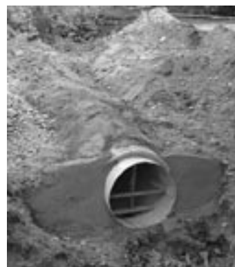
Izgradnja prepusta
