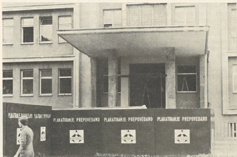
Vhod v tovarno skozi upravno poslopje bo kmalu nared! (stanje 11. IX. 1978)
