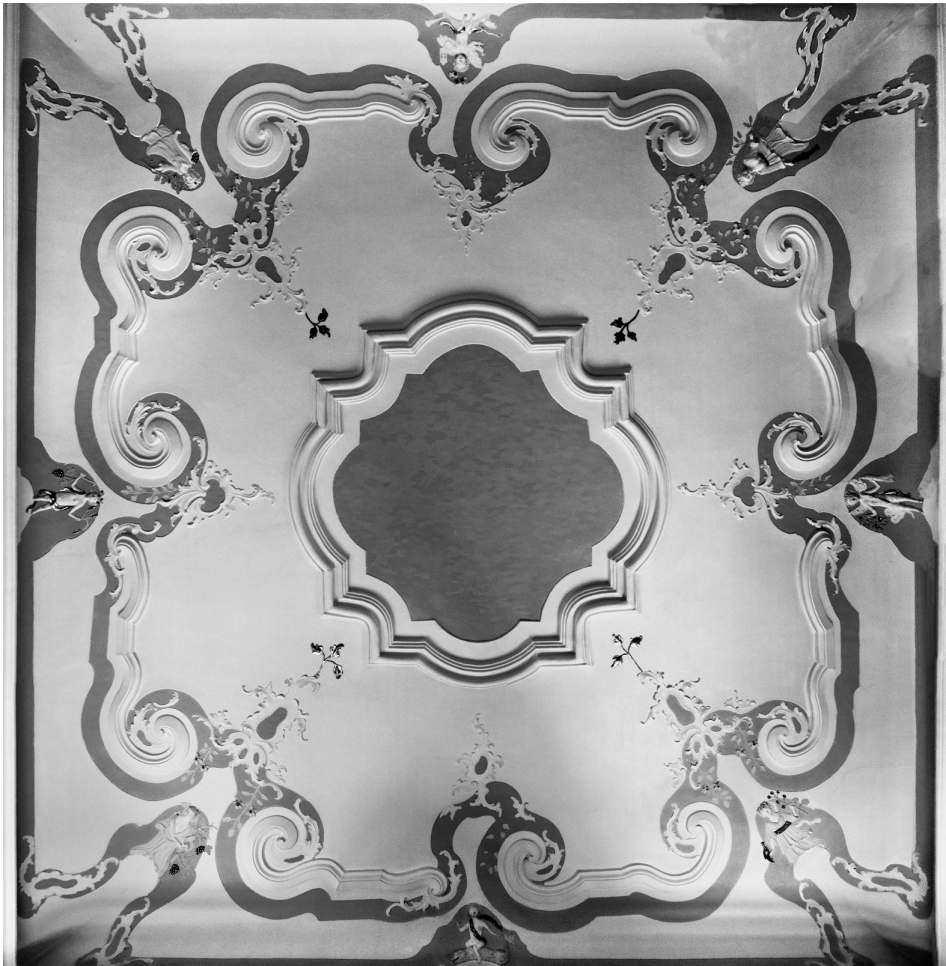
3. Štukature na stropu salona. Izola, palača Besenghi degli Ughi
