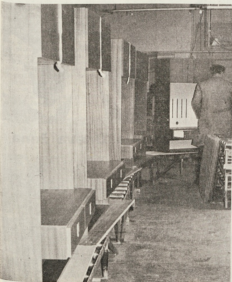
Iz montažnega oddelka v Tovarni pohištva Cerknica
