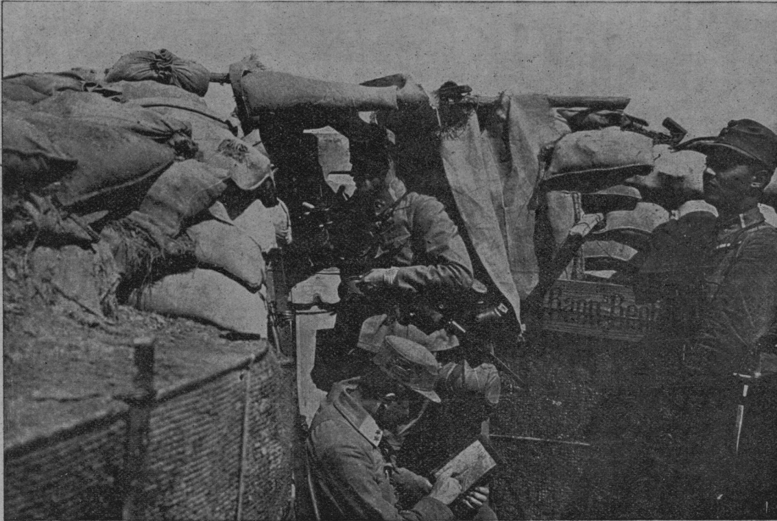
Ob Soči: Strelski jarek, zavarovan z vrečami, polnimi peska, in betoniran. Tu je opazovalnica, ki je telefonično zvezana s poveljstvom.
