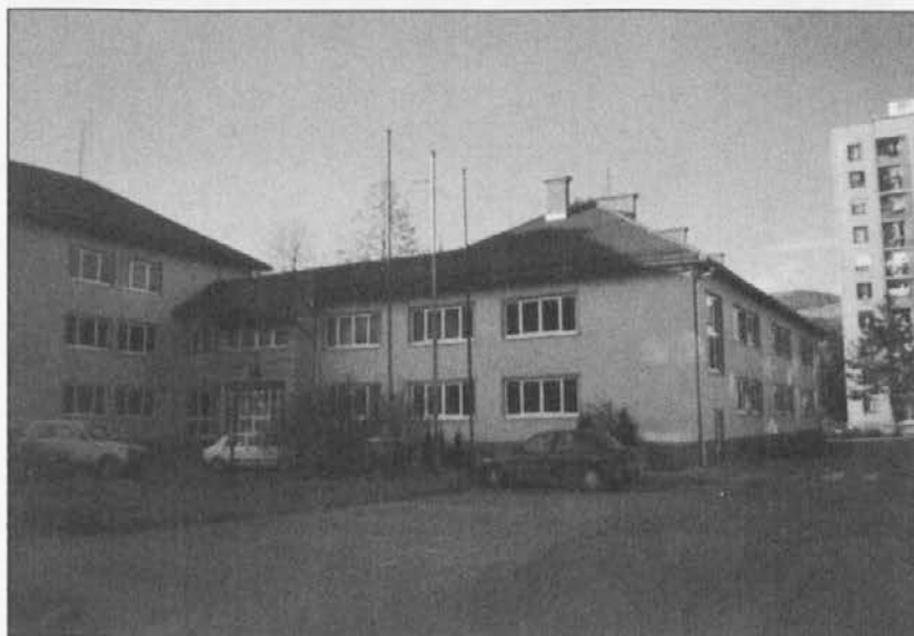
Sedež Upravne enote Ravne na Koroškem na Čečovju
