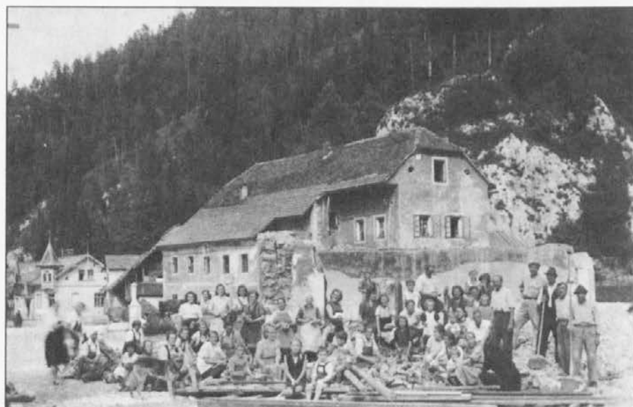
Povojno urejanje centra Črne na Koroškem
