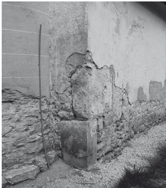
Sl. 15: Podkraj. Arhitekturni blok (št. 9) nad arhitekturnim blokom št. 8. V času posnetka leta 2008 je bila spolija št. 4 še prekrita z ometom (prim. sl. 9).
