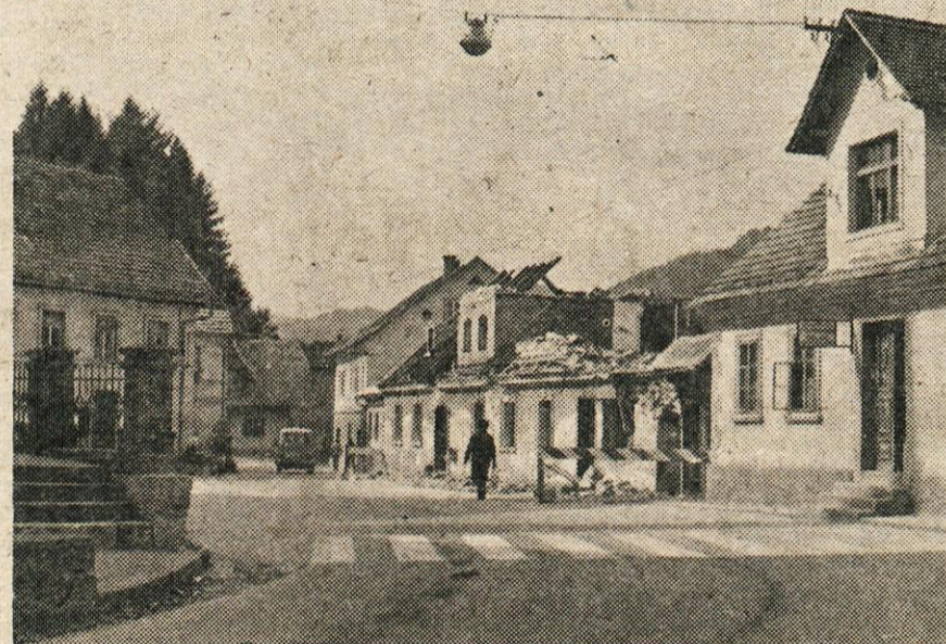
Rušenje „Majolke“ - gradnja novega objekta je v teku
