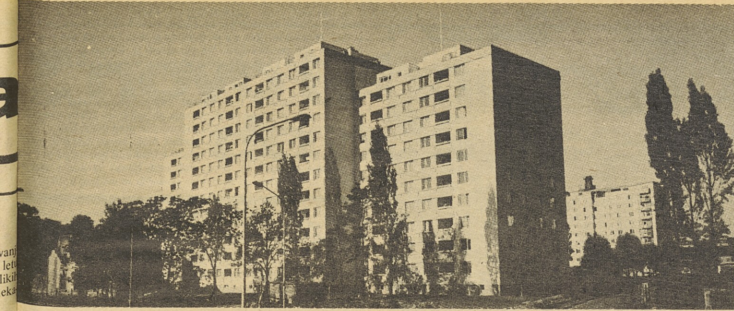
„Stavbar je še posebno ponosen na 220-stanovanjski blok ob Plečnikovi cesti v Mariboru
