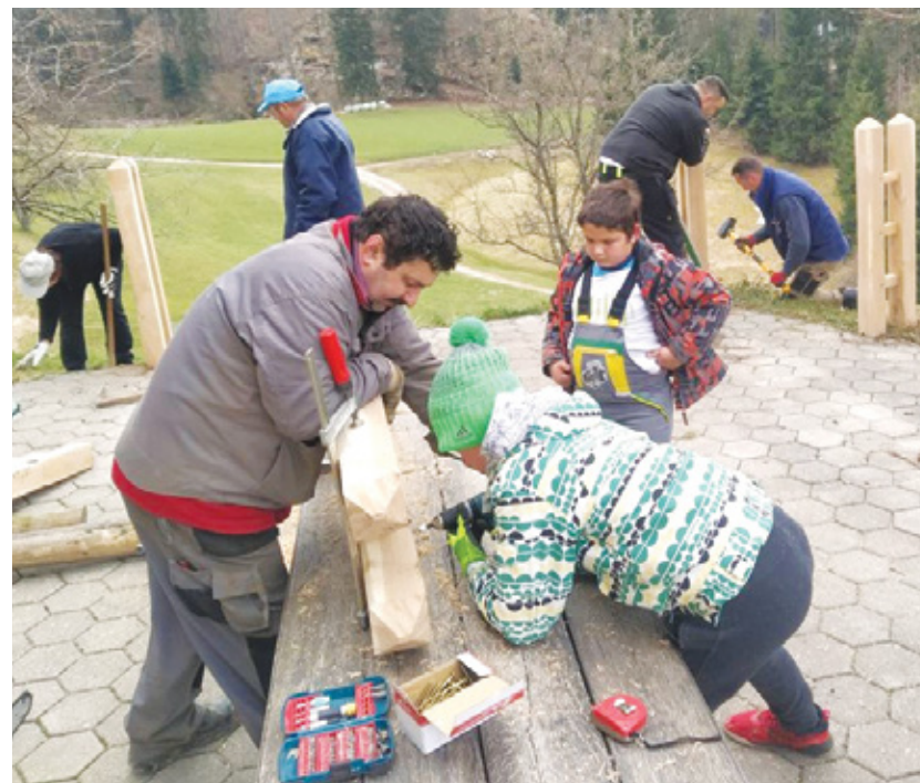
Dela pri obnovitvi ograje
