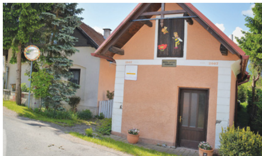
Stavba, v kateri je nekoč živel Anton Pepel, danes pa je v njej muzej
