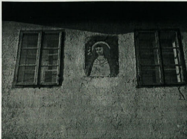
Freska Marija sedem žalosti na fasadi Reharjeve hiše
