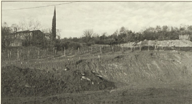
Trasa hitre ceste se mimo kmetije Božič že vzpenja proti vходу v tunel.
