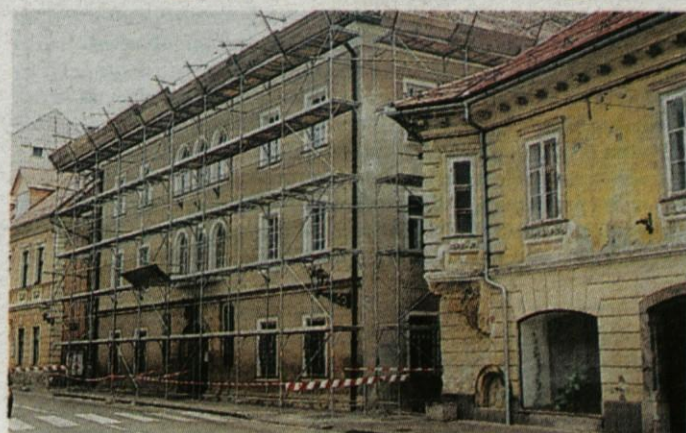
Občinska stavba je te dni že obdana z gradbenimi odri, ki bodo služili prenovi strehe.
