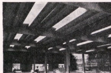
Notranjost montažne konstrukcije hale »Lesnina« v Levcu
