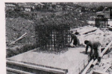
Temelji za montažno halo »Varnost« v Zagorju
