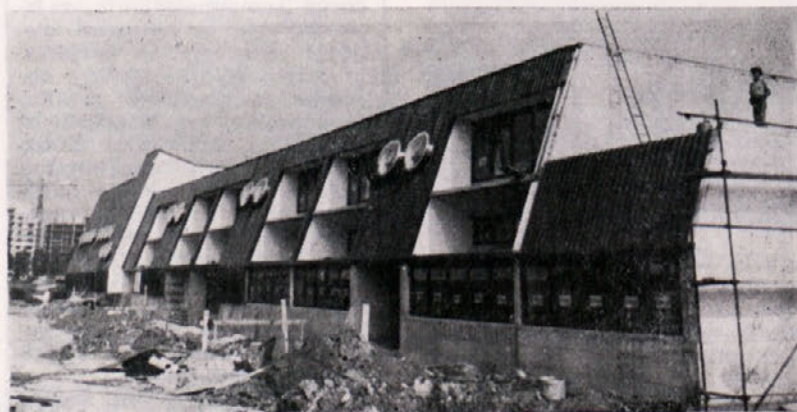
Na objektu osnovne šole v Žalcu hitijo z zaključnimi deli, saj se bodo šolska vrata kmalu odprla.
