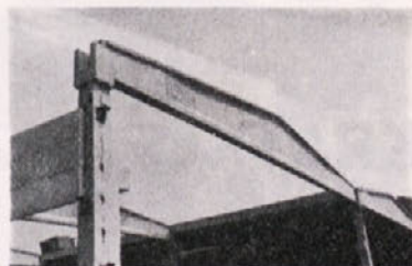
Prvi prednapeti montažni nosilci so bili izdelani za halo v Zagorju
