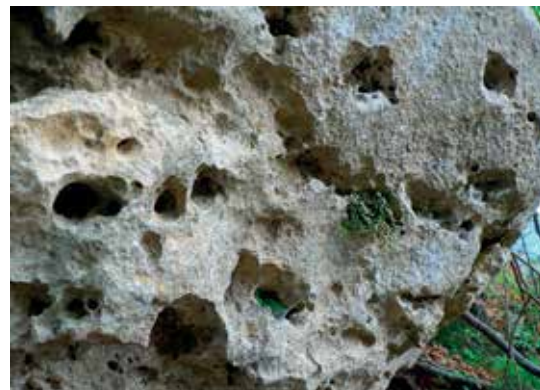
Slika 14: Korozijske razjede v čistem apnenecu kot primer kemičnega preperevanja.
