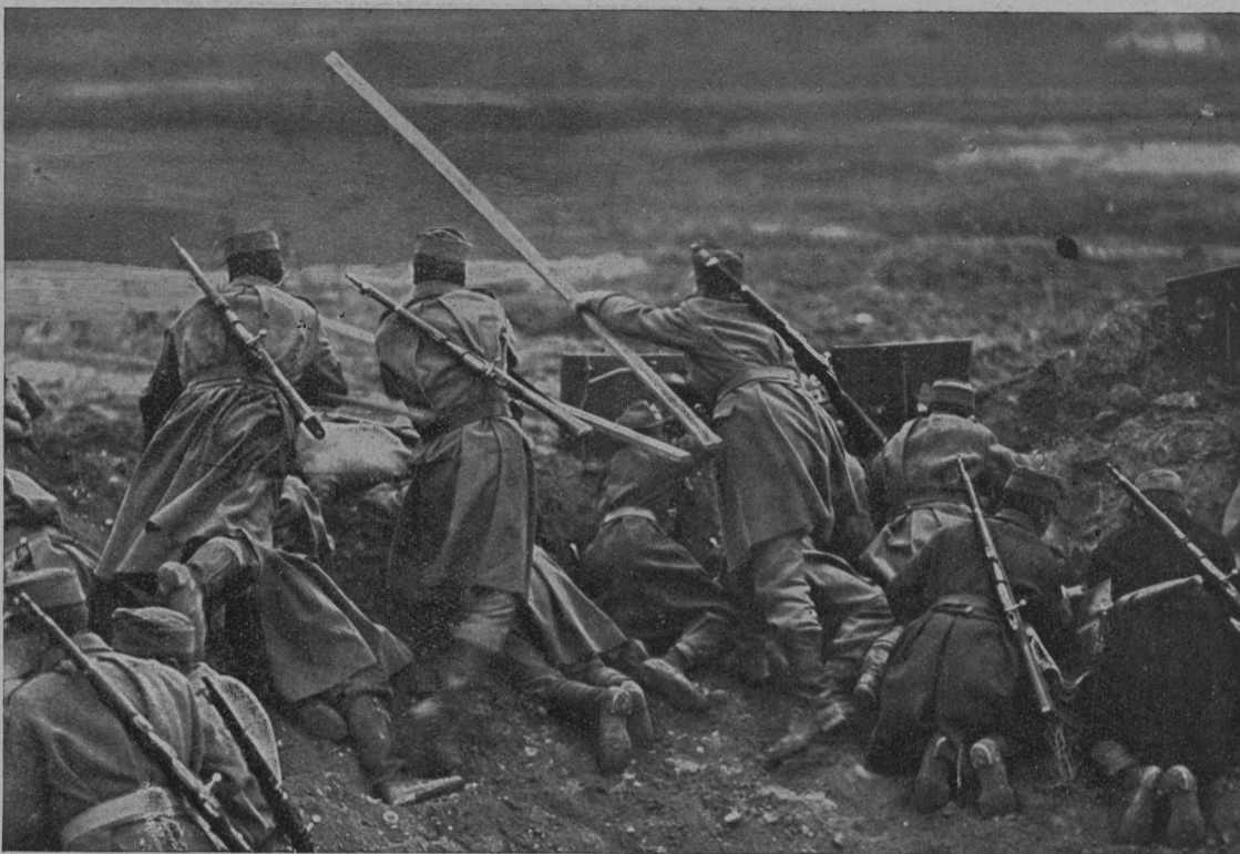
Oddelek avstro-ogrskih saperjev odstranjuje z drogovi in škarjami žične ovire pred laškimi strelskimi jarki, da jih more naša pehota potem z naskokom napasti.
