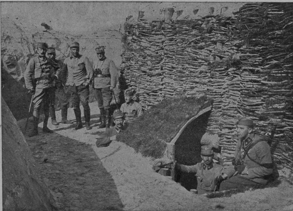
C. kr. domobranski pešpolk št. ... v svoji poziciji na fronti. Vzorno zgrajen strelski jarek in vhod v podzemeljsko kritje (kaverno.)
