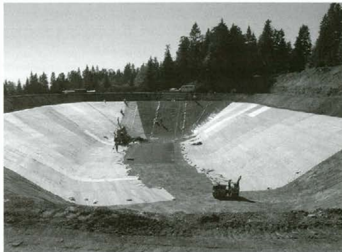
Gradnja akumulacijskega jezera na Kopah.
