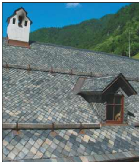
Slika 32: Na novo prekrita streha z zalološkim skrilom Na plavžu v Železnikih. Foto: arhiv DECOP
