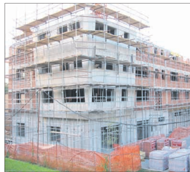
Gradbišče večnamenske stavbe v blokovskem naselju v Štoreh. Iz težko pričakovane večje živilske trgovine nastaja mogočna zgradba.
