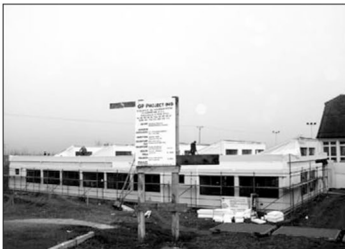
Nov videmski montažni vrtec že dobiva grobo zunanjo podobo.
