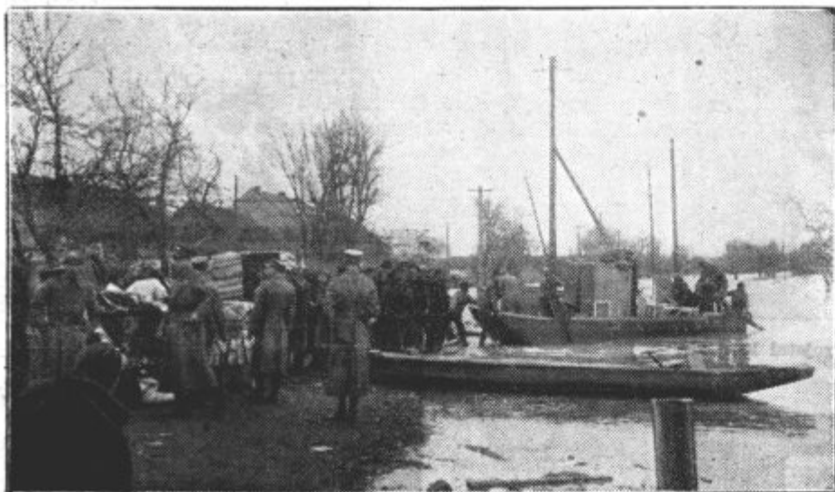
Orošniki se nadzorovali navaševanje nasipov pri Sremskih Karlovcih
