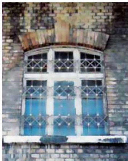
Istvan Bacsak, Venčeslav Čeligoj, luško skladišče XV, 1897-1898, detajl. Zbornik Arhitektura historicizma na Reki (2002).
