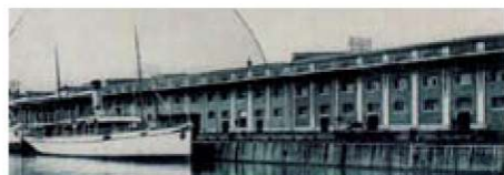
Luška skladišča VI, VII in VIII, po rekonstrukciji 1895-1899, pri kateri je sodeloval tudi Venčeslav Čeligoj. Zbornik Arhitektura historicizma na Reki (2002).
