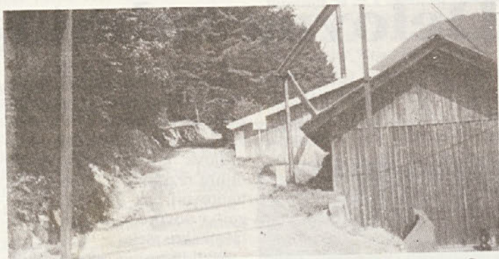
Obnovljena gozdna cesta, ki pelje čez dvorišče našega obrata v Sotški.
