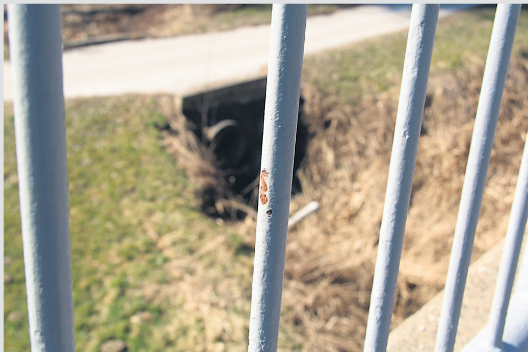
Ni treba biti izvedenec gradbene stroke, da se opazi površno barvanje ograje na borlskem mostu.
