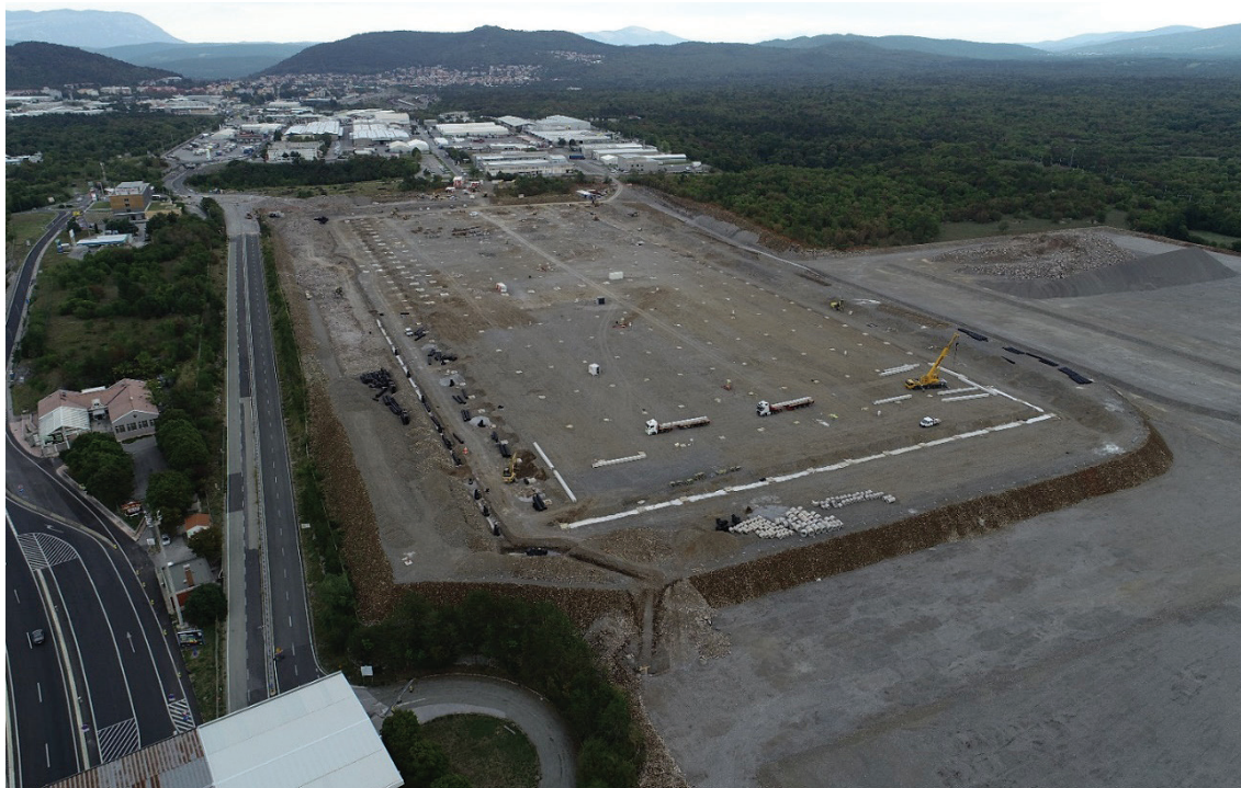
Slika 3. Izvedba temeljev ter priprave na montažo armiranobetonske konstrukcije.
