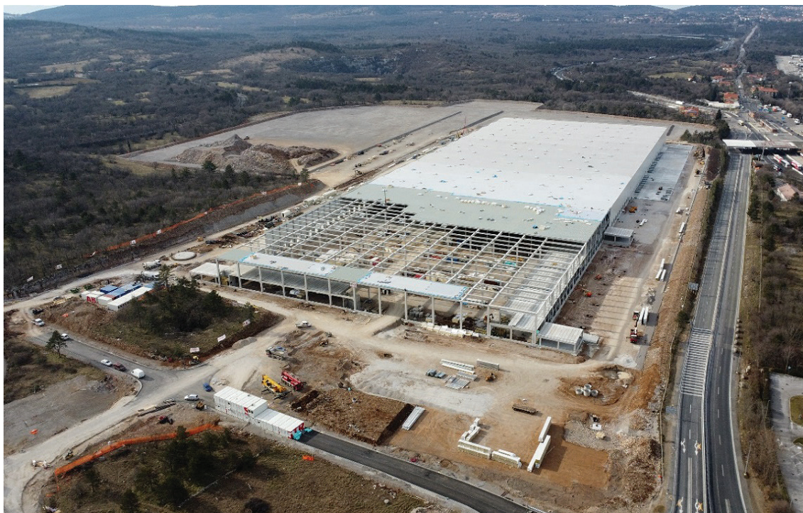
Slika 2. Logistični center s pripadajočo zunanjo ureditvijo v izgradnji.
