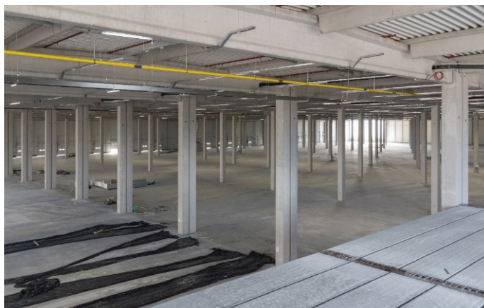
Slika 12. Izvedba inštalaterskih del.
