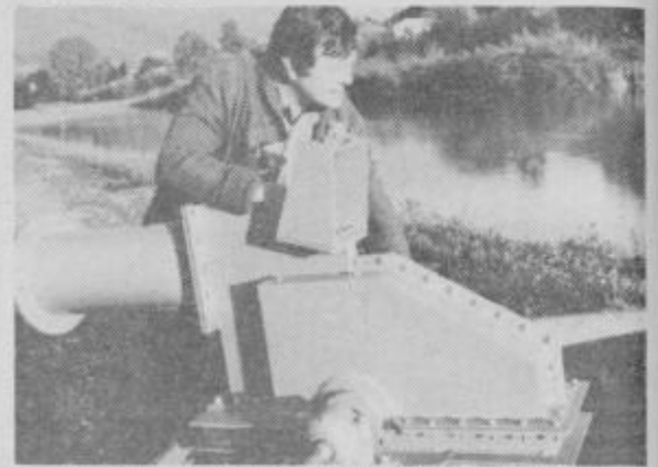
Eden zanimivejših rezultatov Savinjske kooperacije z zasebniki so male vodne turbine, ki jih ponujajo s celotno strojno in električno opremo, turbine pa tudi montirajo. Na sejmu bodo predstavili 25 kilovatno turbino po sistemu Bauli, ki potrebuje za delovanje 150 sekundnih litrov pretoka.
