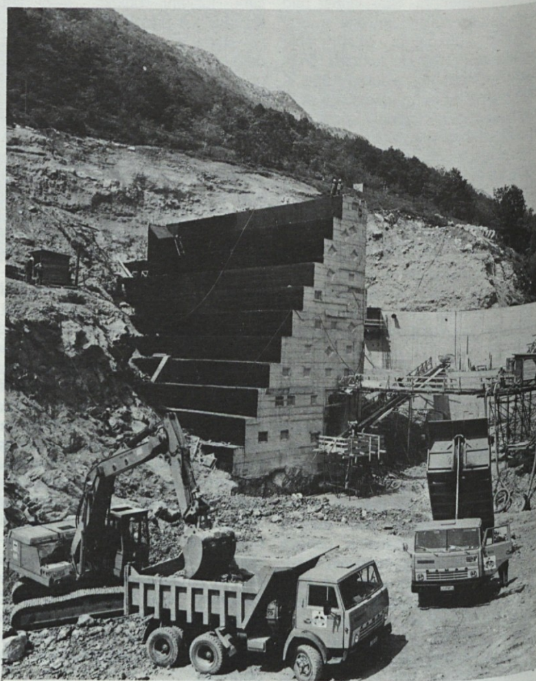
S sodobno mehanizacijo lahko gradimo tako zahtevne objekte
