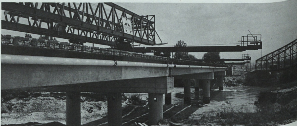
Konstrukcija za montažo nosilcev
