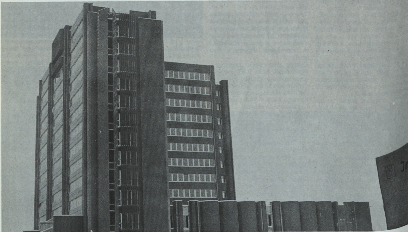
Poslovna stavba SOZD Emona v Ljubljani — primer dobrega načrtovanja (TOZD Biro Ljubljana) in kakovostne izvedbe (TOZD GE Ljubljana- okolica)
