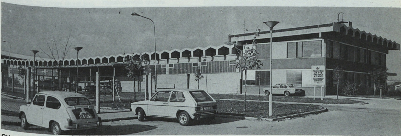
GH-5 — Gradisova montažna hala za PTT Kranj
