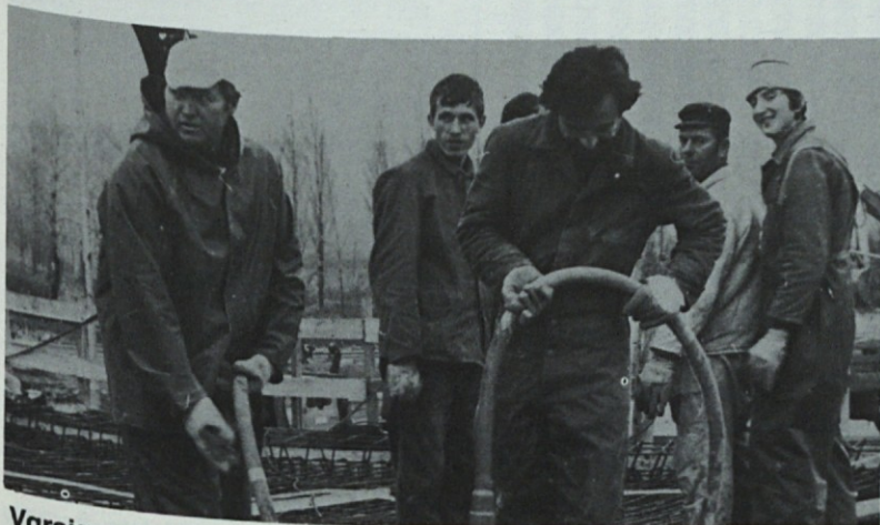
Vgrajevanja betona z vibratorji
