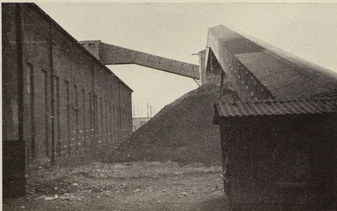
Odprto skladišče boksita
