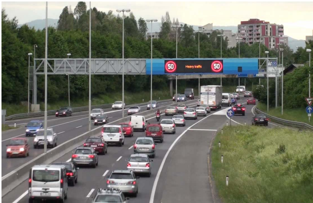
Slika 2-6: Primer ITS ukrepa homogenizacije prometnega toka na ljubljanski obvoznici
