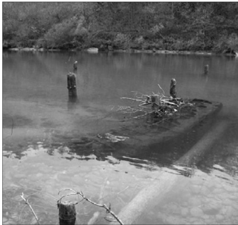
Ostaline nekdanjega vojaškega mostu med Pevmo in Štmavrom
