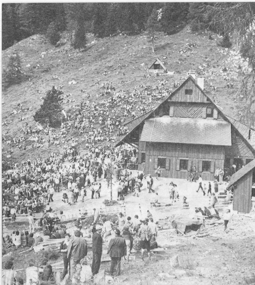
Nova koča na Loki, na zunaj ima podobo stare, znotraj pa je res na sodobnem nivoju
