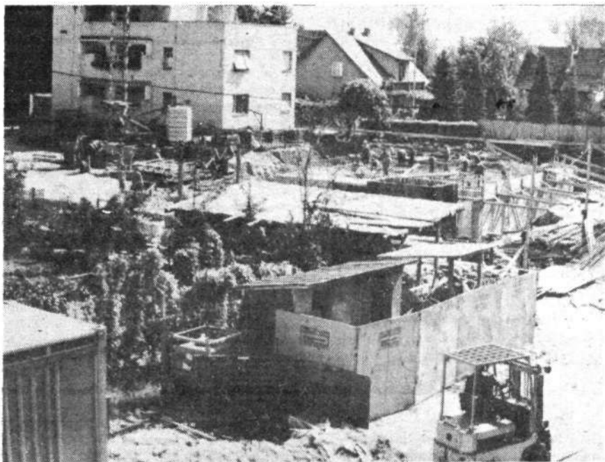
Pred zgradbo TOZD Papirkonfekcija je že »zapolnjena« gradbena jama. Na temeljih in kletnih prostorih bo zrasla nova proizvodno-skladiščna hala.
