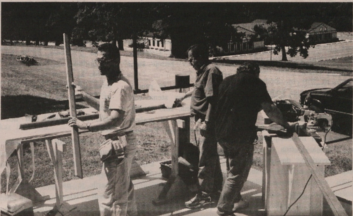
Slovenski delavci, ki so zaposleni pri podjetniku Francu Tivadarju, pripravljajo okvirj za odprtino v cerkvi zadaj in okrasne letve
