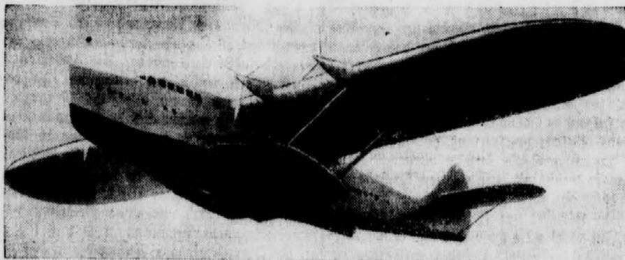
Auf Grund der Erfahrungen, die man mit den bisherigen drei Flugschiffen der Do-Klasse machte, bauen die Dornier-Werke nunmehr ein neues Flugschiff Do 20, dessen Modell zum erstenmal auf der Internationalen Luftfahrt-Ausstellung in Stockholm der Öffentlichkeit gezeigt wird. Das Flugschiff wird mit acht Dieselmotoren von je 800 bis 1000 PS getrieben und hat bei einer Durchschnittsgeschwindigkeit von 250 bis 300 Kilometerstunden einen Flugbereich von 4000 bis 5000 Kilometer. (Wertbild.)
