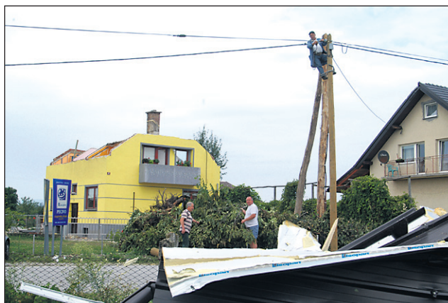
Orkanski veter je besnel tudi v ulici Na postajo, saj so brez strehe ostali Visenjakovi (na posnetku) ki bodo razpokano in razmočeno hišo verjetno morali v celoti potreti.
