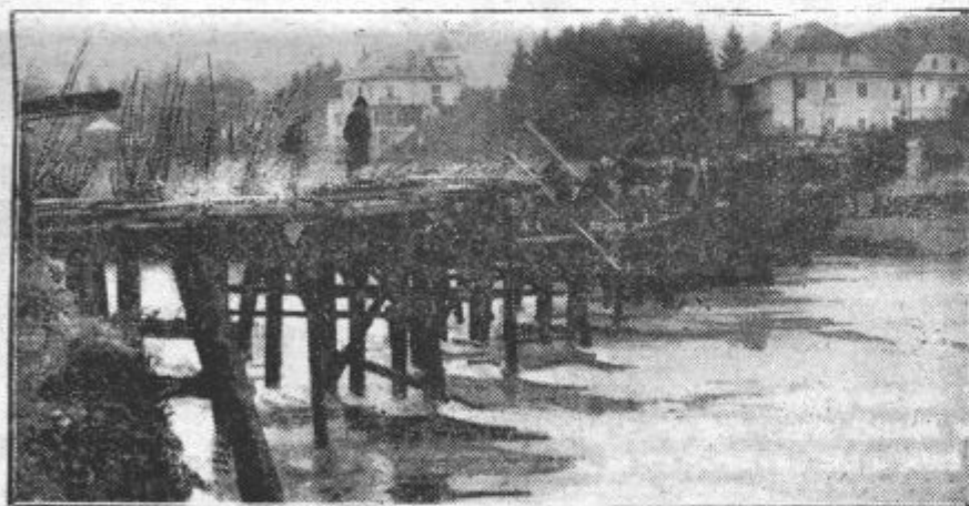
Na desni: Most čez Savo v Tacnu pod Šmarno goro so morali popolnoma zapreti za promet, ker se je na tretjem stebri na vižmarski strani pojavila velika razpoka in se je nagnilo železno ogrodje.
