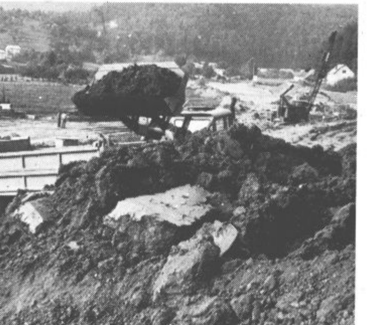
V začetku avgusta so delavci SGP Slovenijec iz Ljubljane začeli dela na cestnem odseku Šalek-Salo. Na gradbišču je 35 delavcev in kot kaže posnetek, so dela v polnem teku.
