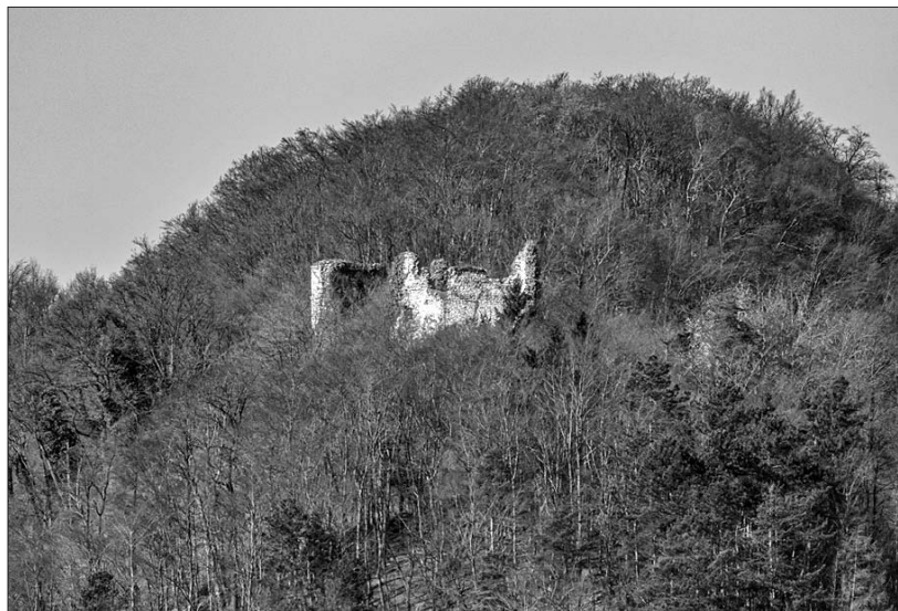
Zbelovo. Pogled na ruševine gradu Plankenstein z vzhodne strani (foto: Slavko Ciglenečki).
