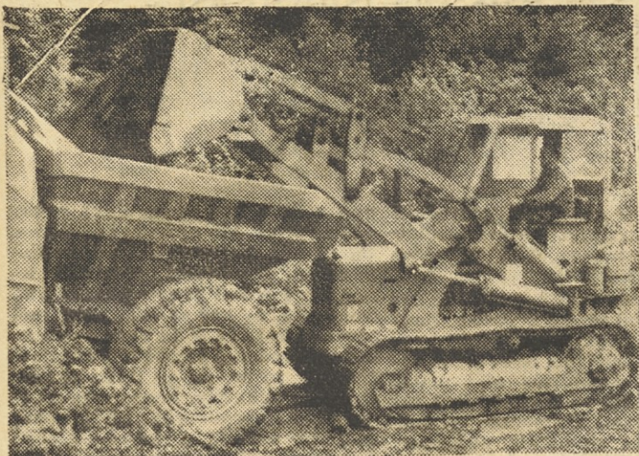
Zemeljska dela opravljajo večinoma s stroji. Tovariš Filipčič na nakladišču
