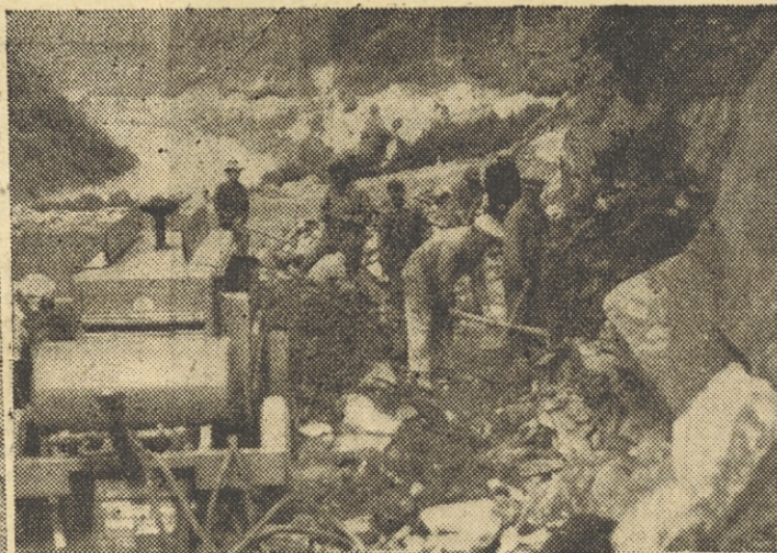
Zemeljska dela so v glavnem pri kraju. Izkopati bo treba še kakih dva do tri tisoč kubikov
